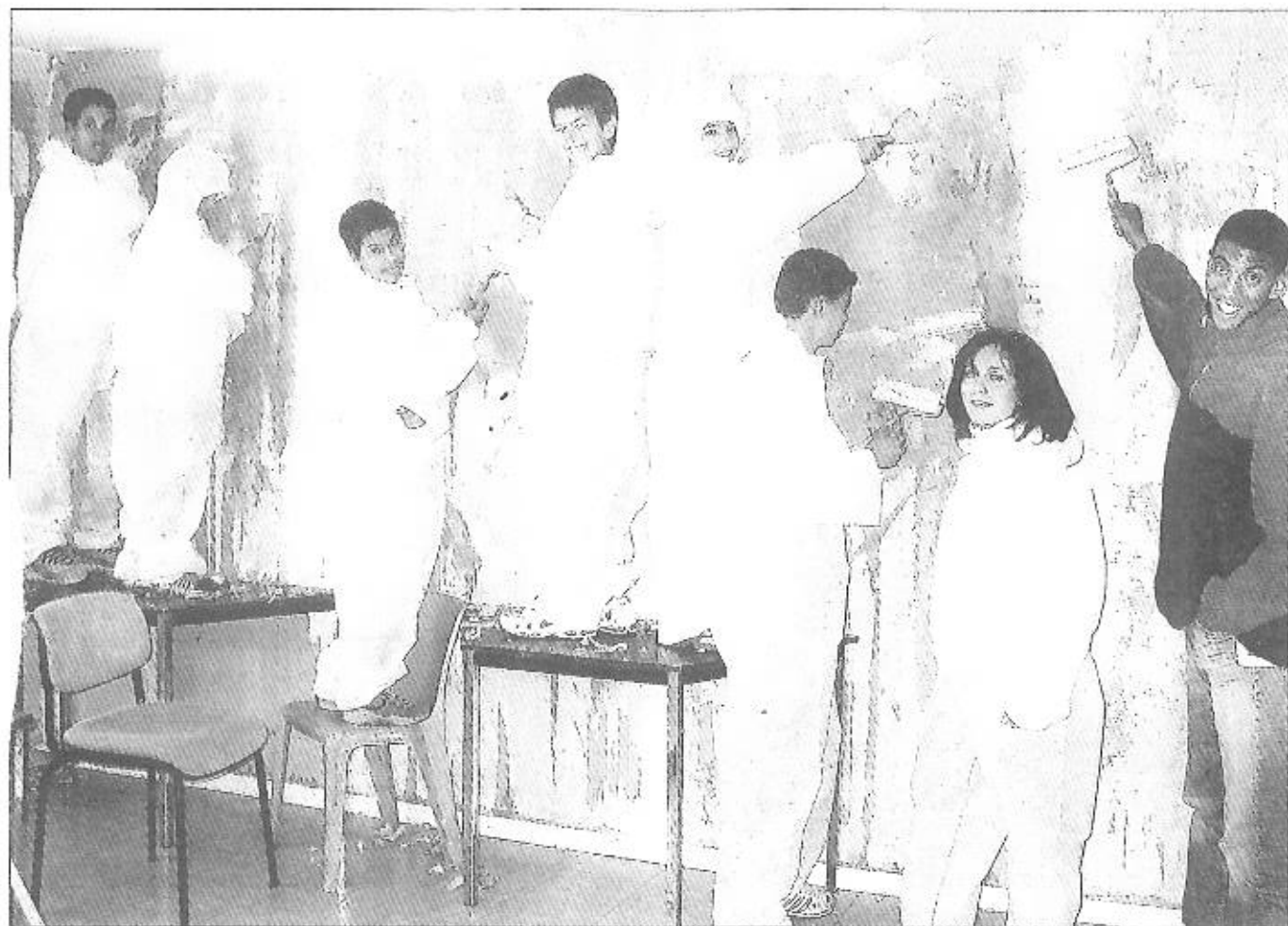
Mission chantier jeunes : embellissement des locaux
